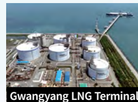
Gwangyang LNG Terminal
